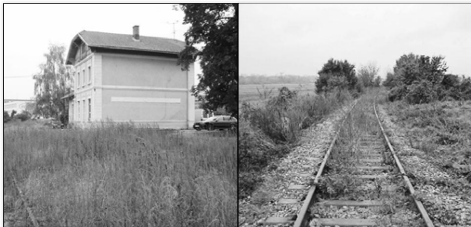
Osiřelé nádraží v Židlochovicích a opuštěná trať místní dráhy Hrušovany–Židlochovice, foto archiv kronikáře
